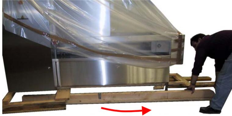
Nun wird die Maschine wieder auf den Boden abgelassen. Die Hubwagen werden entfernt. **Bitte beachten Sie dass die Maschine nicht ruckartig abgesetzt wird**, die Maschinenstollen könnten zerstört werden.
