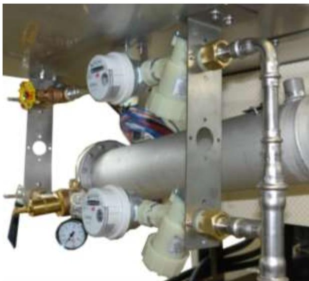
Onde evitare danni di trasporto in certi casi si possono smontare le conduzioni idriche. Queste si devono naturalmente rimontare prima della messa in funzione.
